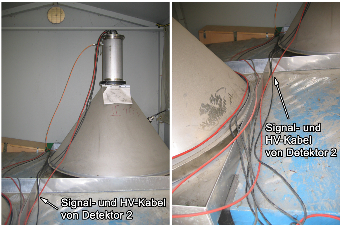
Abbildung D.2: Anordnung der Signal- und HV-Kabel des Detektors am KASCADE-Experiment für Detektor 2 im Innern einer Detektorstation in Cluster 2, so dass das Störsignal reproduzierbar reduziert werden kann. Die beiden schwarzen Kabel sind Anoden- und Dynodensignalkabel, das Rote ist das HV-Kabel. Das Anodenkabel sollte möglichst nahe an der Wanne von Detektor 1 liegen (links im Bild zu erkennen), damit die kapazitive Wirkung zwischen Wanne und Bleiplatte (unter den Wannen der Detektoren) groß wird.
