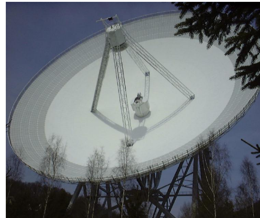
Effelsberg, Duitsland diameter: 100 m Resolutie ( \lambda 21\text{cm} ) \theta = 0,12^\circ
